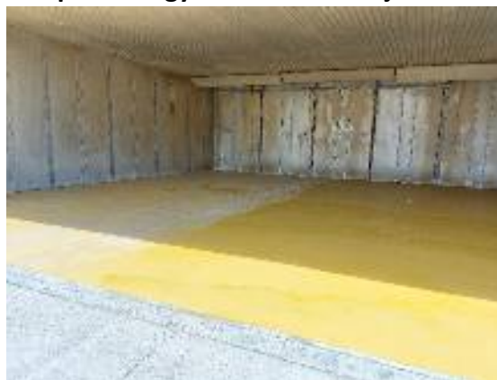
Saválló műgyanta vastag-bevonat készítés parketta gyár szárító kamrájában
